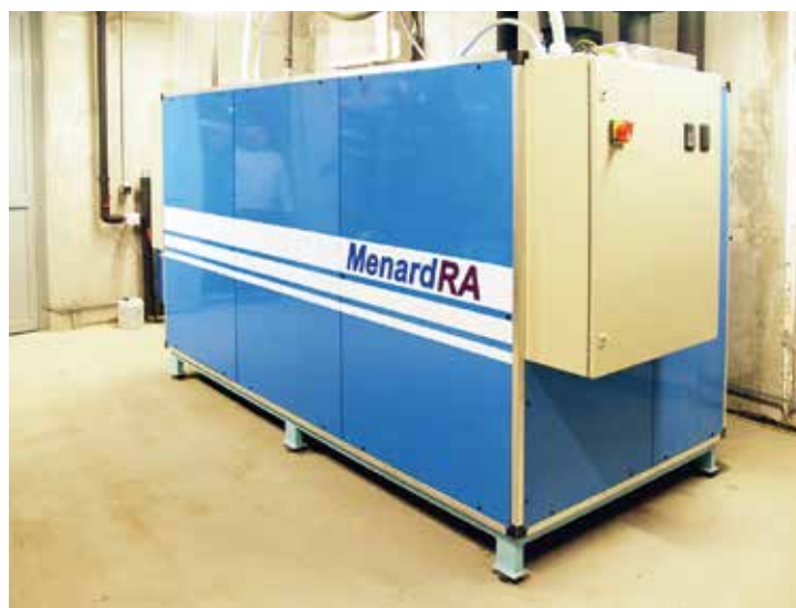
Toplotna črpalka VODA/VODA 600 kW.
